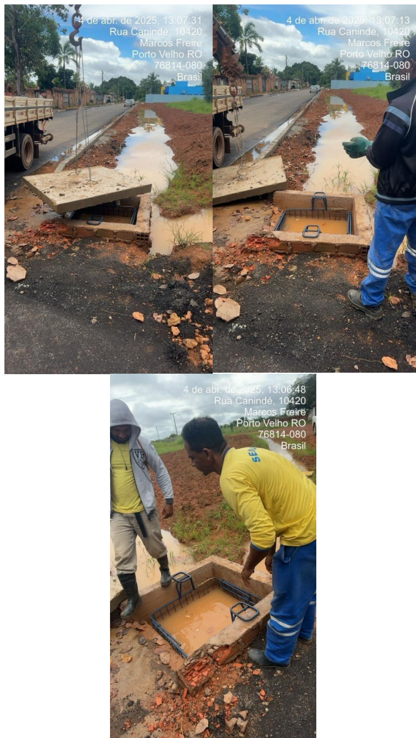
Figura 03 -Instalação de ecobueiro ajustável com alça e suporte de sustentação elevada, modelo feito com vergalhões, Bairro Marcos Freire próximo ao Cras Dona Cotinha.
