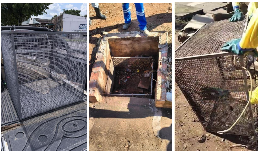
Figura 01 -Confecção de gaiola com tela galvanizada ondulada e instalação na Av Rio de Janeiro c/ Av. Guaporé.
