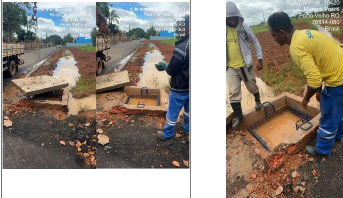
Figura 03 -Instalação de ecobueiro ajustável com alça e suporte de sustentação elevada, modelo feito com vergalhões, Bairro Marcos Freire próximo ao Cras Dona Cotinha.
