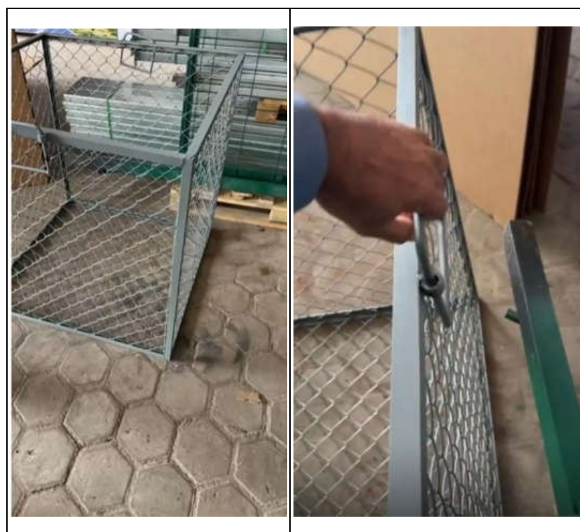
FIGURA 02 - CONFECCÃO DE GAIOLA COM TELA GALVANIZADA PARA ALAMBRADOS COM ALÇA RETRÁTIL INSTALADO NA AV RIO DE JANEIRO C/ AV. GUAPORÉ.
