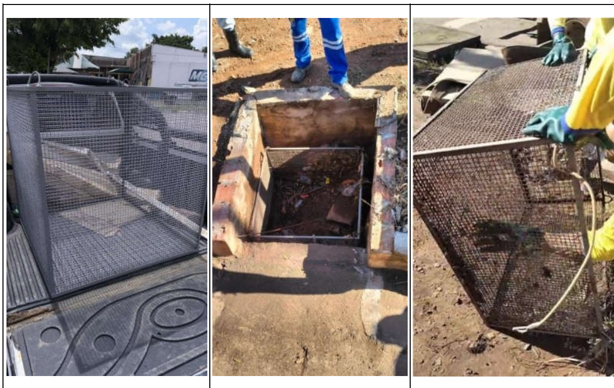
FIGURA 01 -CONFECCÃO DE GAIOLA COM TELA GALVANIZADA ONDULADA E INSTALAÇÃO NA AV RIO DE JANEIRO C/ AV. GUAPORÉ
